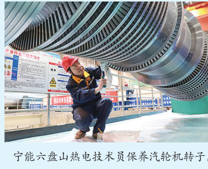
宁能六盘山热电厂技术员保养汽轮机转子。
