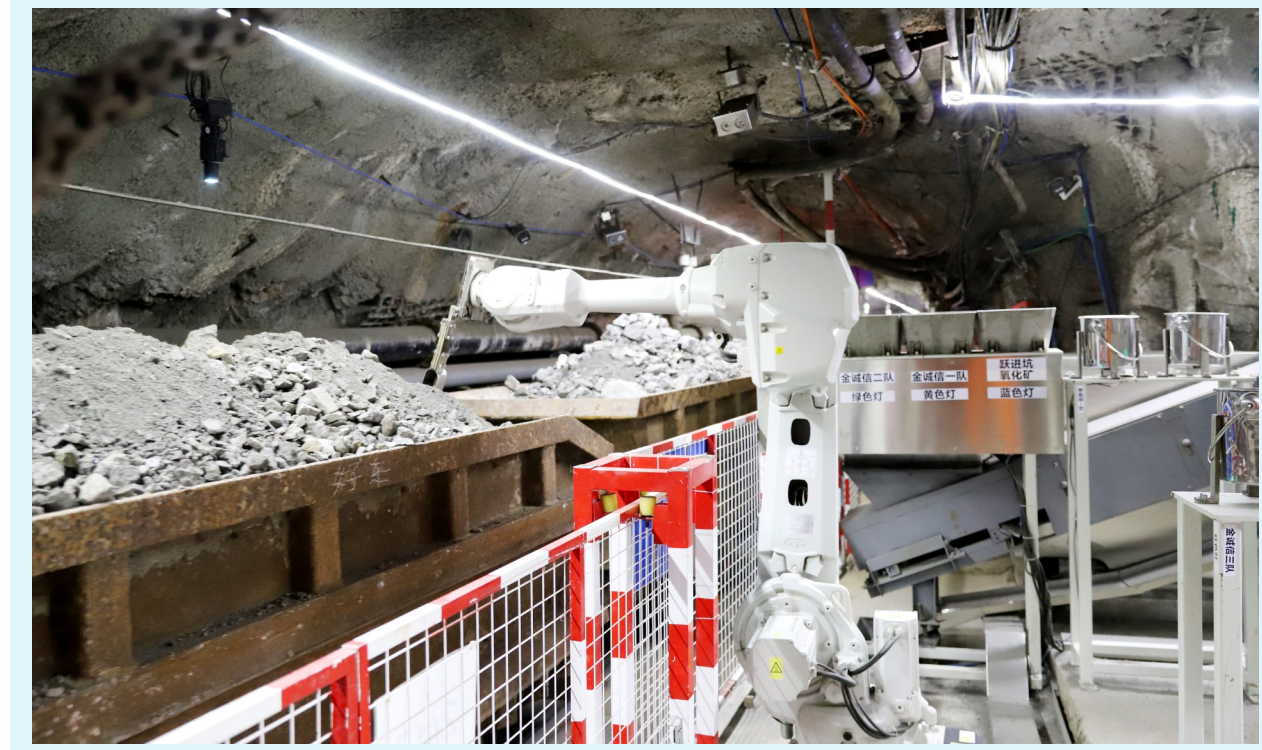
▲图为会泽矿业智能取料机手作业场景。
