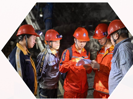
图为彝良驰宏工程建设团队在井下讨论超前探水方案。 李华 摄
