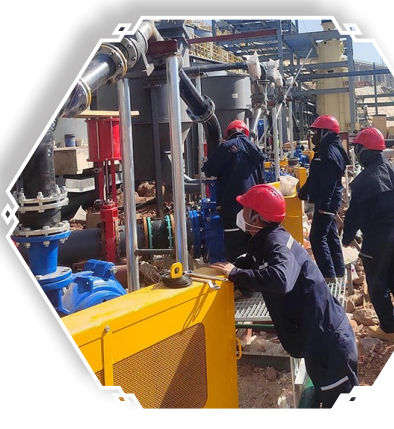
图为项目建设现场。柳国娅 摄
