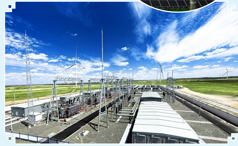
图为包头铝业新能源发电项目现场。 乌兰布赫 摄
