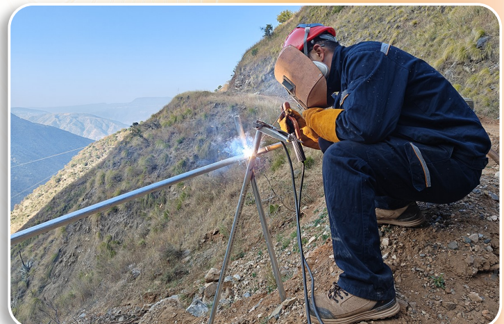
生活用水管道。图为凉山矿业员工帮助周边村民安装王宗珍 摄
