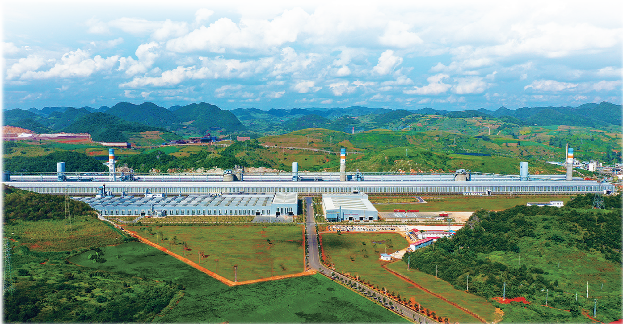
图为云铝文山年产50万吨绿色水电铝项目电解片区全景图。项目创新采用行业领先的智能电解槽与自适应控制技术,以科技赋能打造绿色低碳铝产业智能示范标杆。 夏兴 摄
