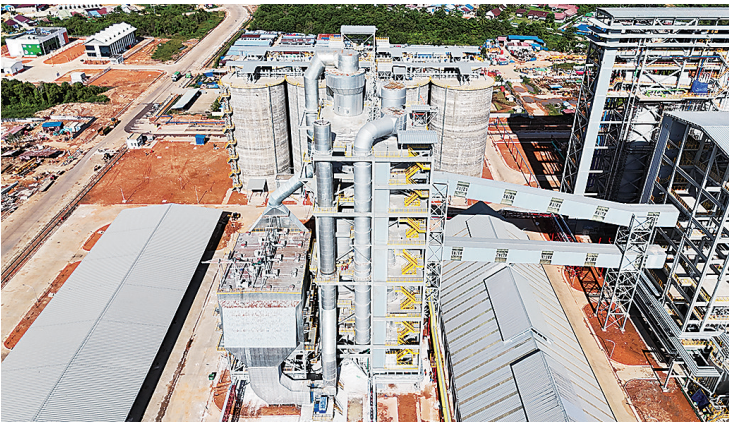
▲图为印尼氧化铝项目氧化铝焙烧炉。 冯嘉飞 摄
