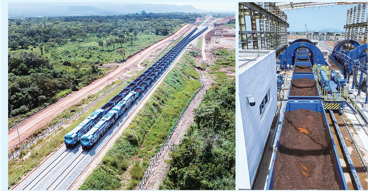
▲图为首批铁矿石铁路运输现场(左)和卸车现场(右)。
