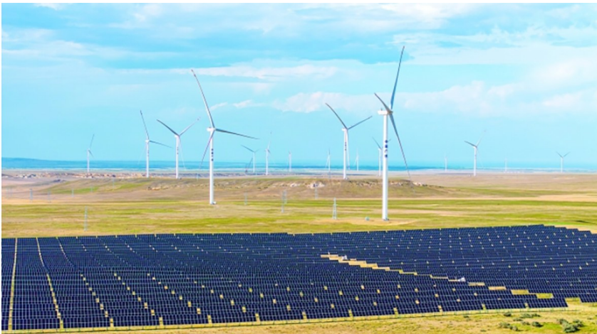
图为新疆阿勒泰地区吉木乃县50万千瓦风电项目配套输电线路建设现场。 图片来自新华社
