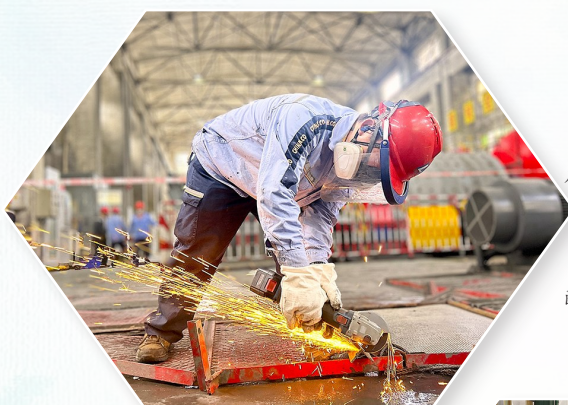
▲图为凉山矿业选矿厂员工切割角钢。 杨敏 摄
