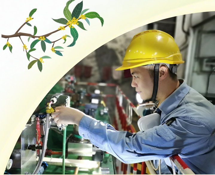
图为玉溪矿业员工在设备开机前进行油管压力检查,确保设备稳定高效运行。 邓晶晶 摄
