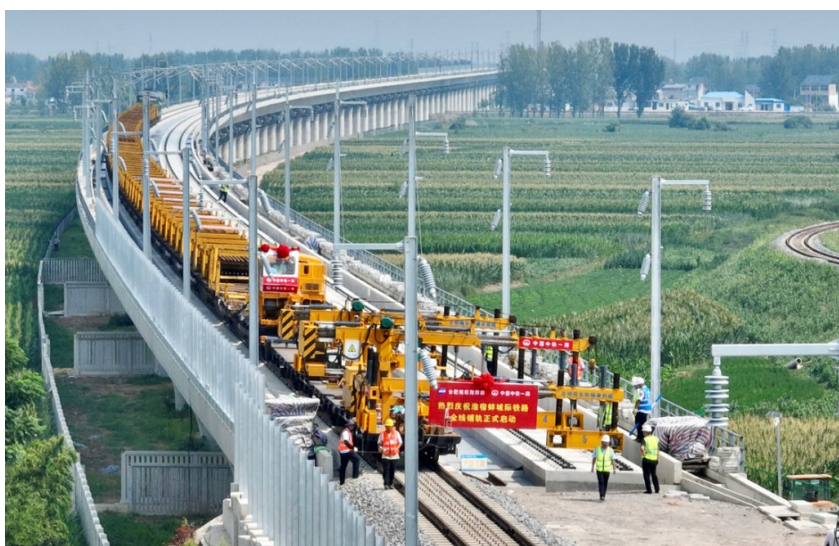
图为中铁一局施工人员在淮宿蚌城际铁路铺轨施工现场作业。图片来自新华社
