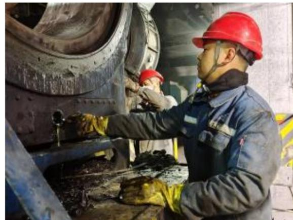
为降低锅炉非计划停炉次数，近期，热电厂利用5号锅炉停炉机会，对5号锅炉进行项目检修，此次项目检修检查内容主要包括水冷壁、省煤器、设备辅机、乙磨衬板等40余项，截至目前，已更换高温段省煤器管140余排，检查消缺35项。图为员工正在进行检修作业。
